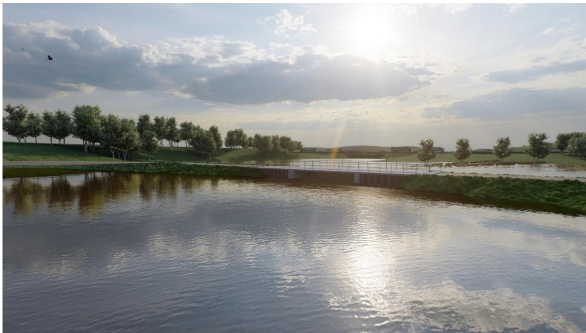
Figur 18 Dæmning i 200 meters afstand, magasin fuldt udnyttet, set opstrøms for dæmning.
