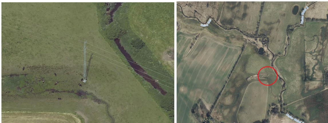
Figur 43 Skrå- og ortofoto af elmast ved Vester Nebel Å, cirka 500 m fra dæmning ved Egtvedvej.
