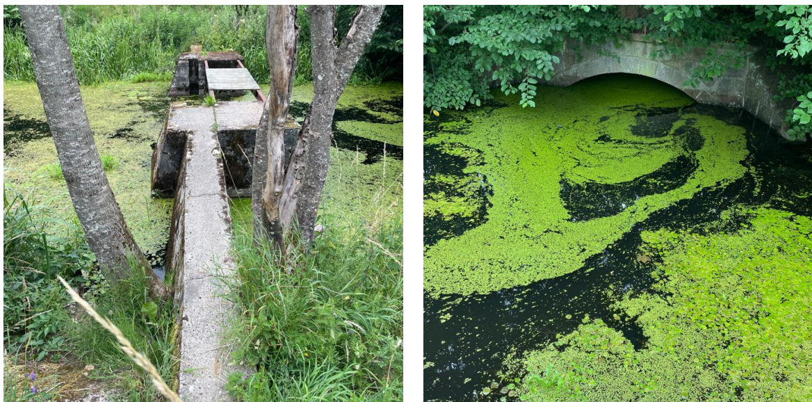
Figur 46 Ældre bygværk i Ferup Kanalen umiddelbart vest for Koldingvej. Th. ses underløb under Kolding Vej ca. 20 m. øst for det gamle bygværk.
